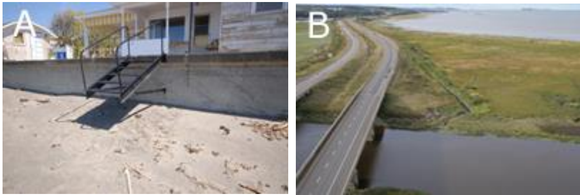
Photo 47 Effets du resserrement côtier : A) abaissement d'une plage en présence d'un mur de soutènement (MSP); B) resserrement d'un marais côtier en érosion au Bas-Saint-Laurent (UQAR – LDGIZC)
