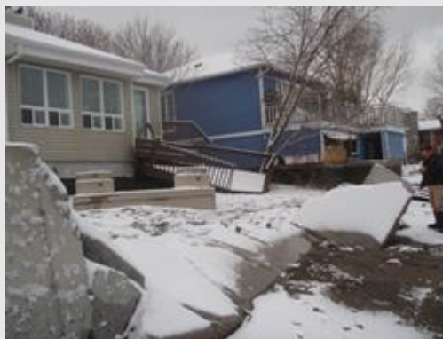
Photo 49 Résidences endommagées à la suite de la tempête du 6 décembre 2010 à Sainte-Luce dans le Bas-Saint-Laurent (UQAR-DGIZC)
