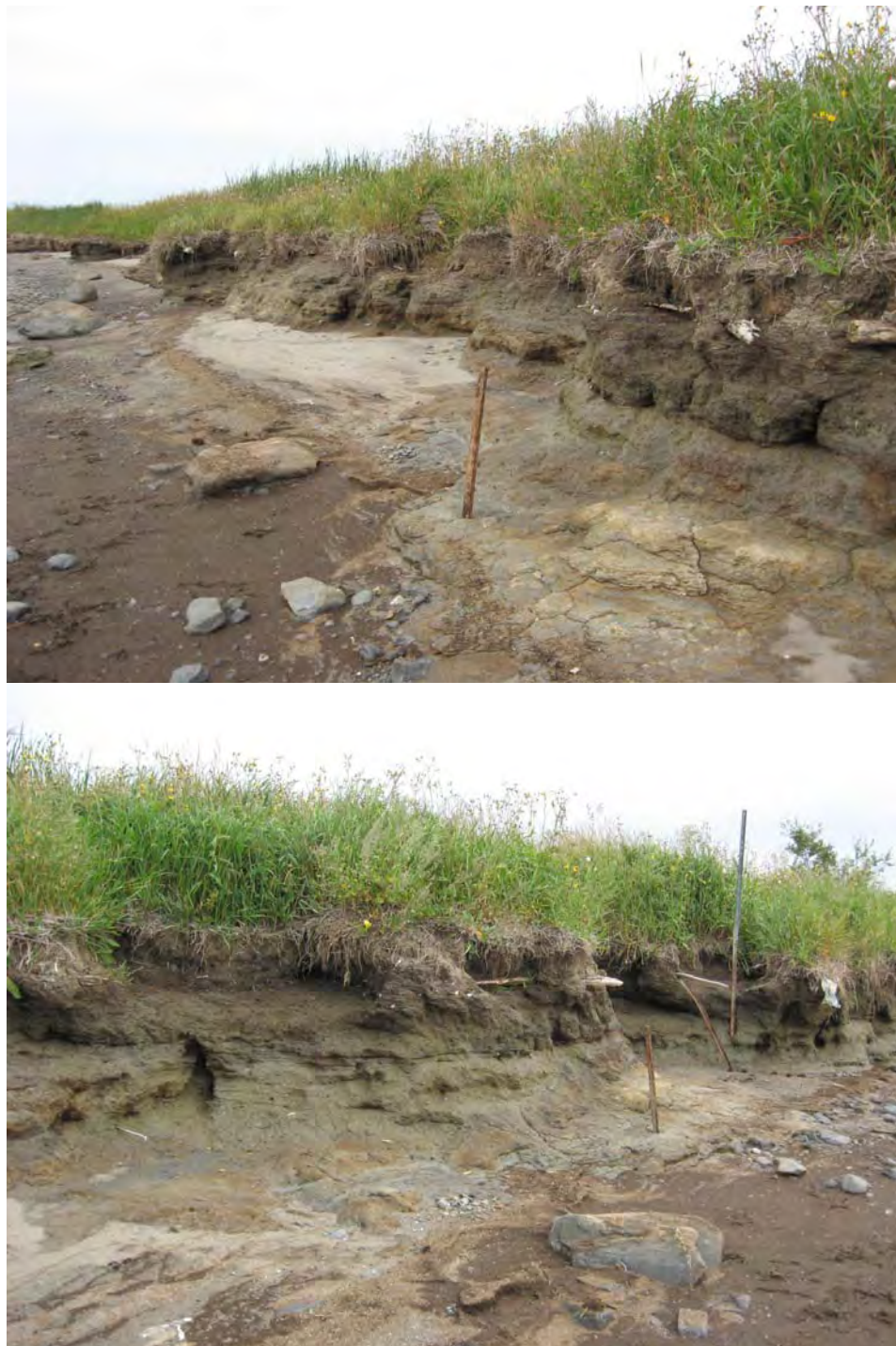
FIGURE 2 : POTEAUX DÉLIMITANT L'EMPRISE DE LA ROUTE
