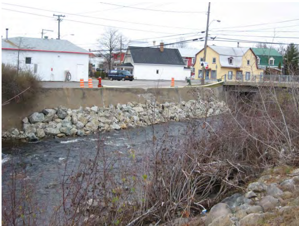
FIGURE 2 : RÉPARATION TEMPORAIRE AU MUR DE PROTECTION DANS LE SECTEUR DU PONT GARIÉPY ET DE LA RUE MORIN
