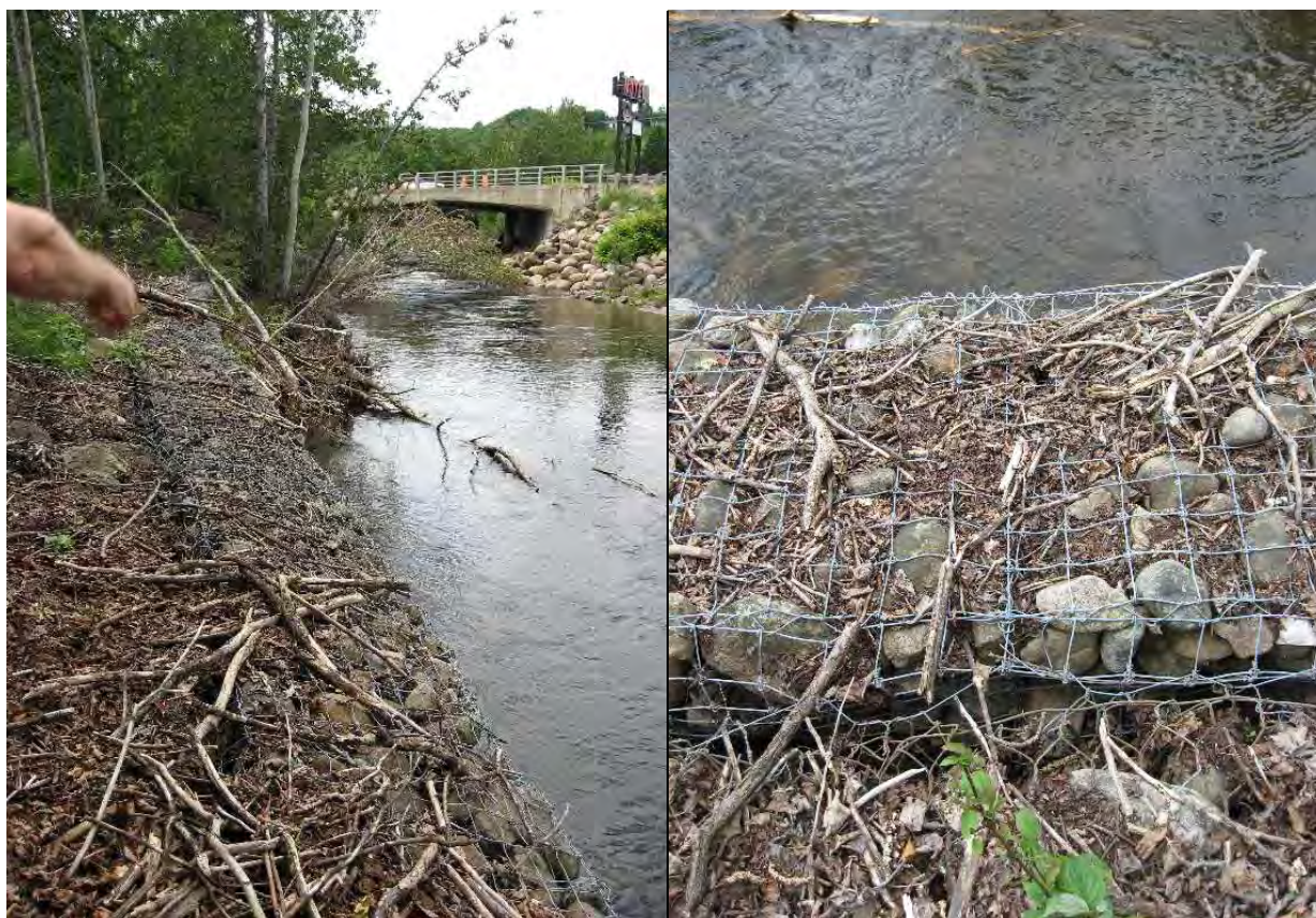
FIGURE 5 : SECTEUR EN AVAL DU PONT DE LA ROUTE 138
