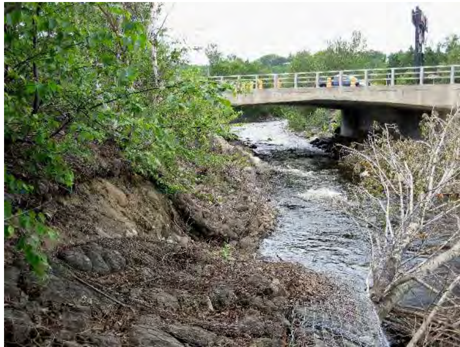
FIGURE 6 : SECTEUR EN AVAL DU PONT DE LA ROUTE 138
