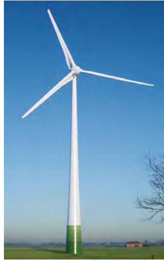
FIGURE 2 : ÉOLIENNE E-82 D'ENERCON
