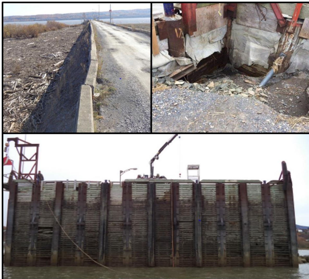
Figure 4 : État actuel du quai
