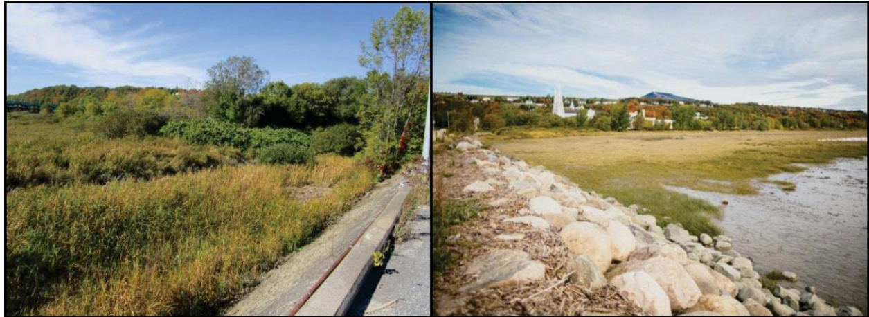
Figure 5 : Zone d'étude autour du quai de Sainte-Anne-de-Beaupré
