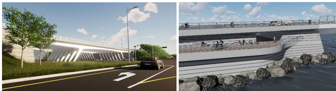
FIGURES 6 &amp; 7 : PONT D'ÉTAGEMENT (GAUCHE) ET CULÉE DE L'APPROCHE NORD (DROITE)
