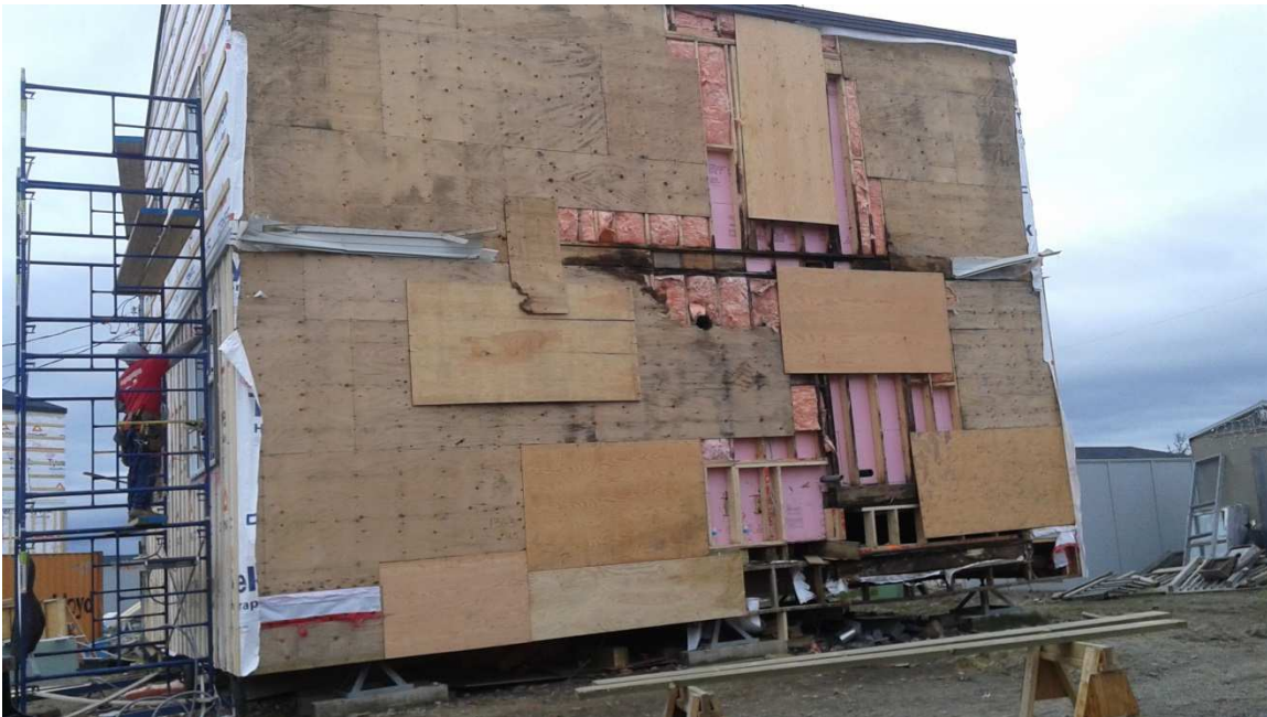
Photographie 17 : Rénovation d'un duplex, Kuujuaq (Source Pierre-Luc Dessureault)
