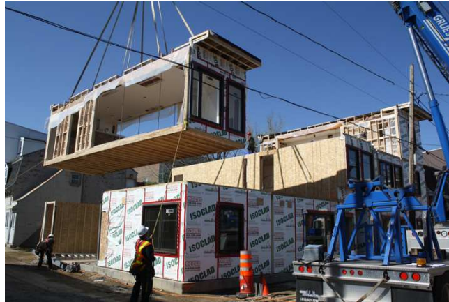
Photographie 2 : Exemple de construction modulaire
