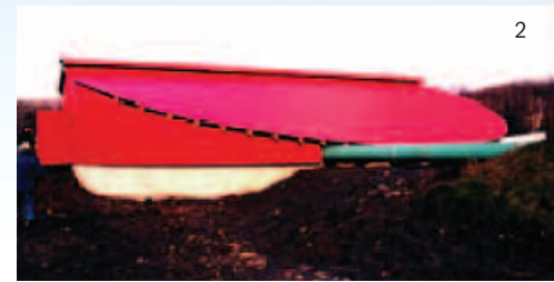
2 Toiture constituée de fermes en bois (de largeur variable) et de tôle
